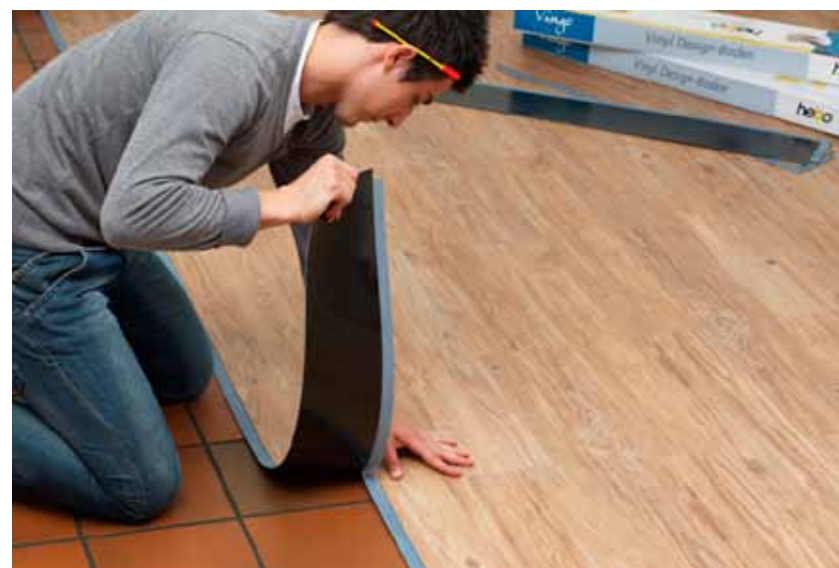
PVC- Bodenbelag in Holzoptik über beste- henden Fliesenbelag geklebt
